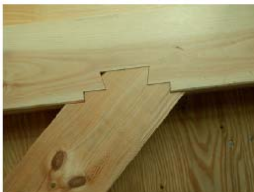
写真 26ーカット工場で行われる木材同士の接合
