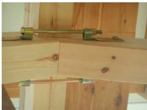
写真 24ー力学的接合により棟の合掌部分における連続性を維持
