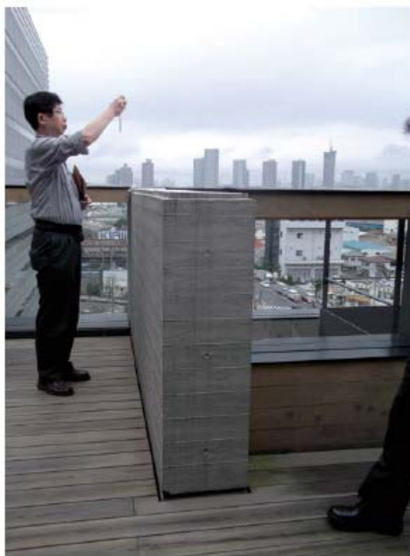
写真 11—木材の床面の色は、時間の経過とともにコンクリート構造材の色に近づいていく。
