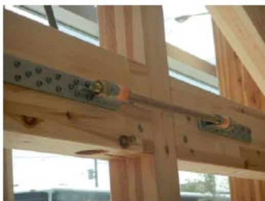
写真 25ー金属製タイロッドによる耐震用壁体補強金物の再現
