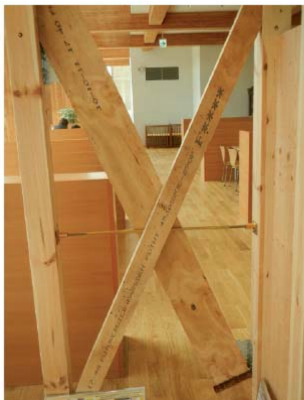
写真27-X型に組まれた木材と中間部の金属製タイロッドにより実現される補強柱間帯
