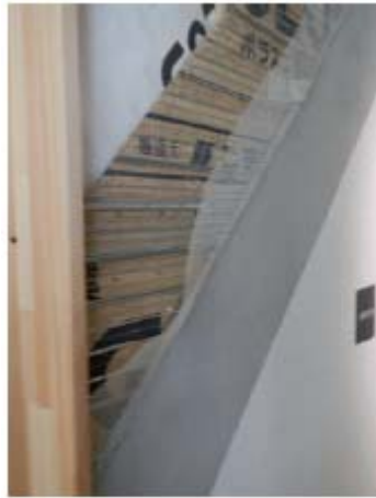
写真 29—シリコンペーパー上のリブメタルラス（外側塗り壁下地）
