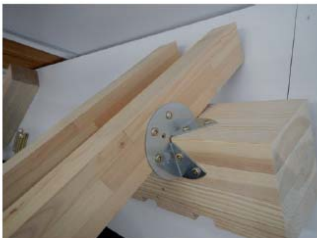
写真 32 一桁上への垂木の接合を可能とする 3D コネクター
