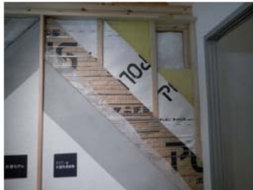
写真 30—シリコンペーパー上のリブメタルラス（外側塗り壁下地）および骨組みの縦材間の断熱材
