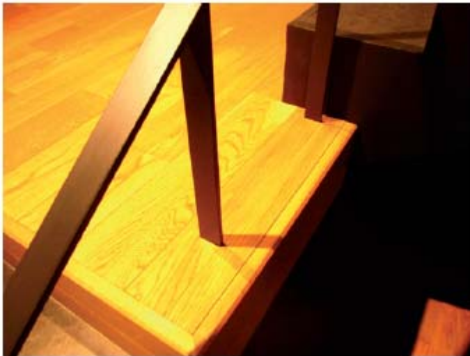
写真 18—階段手すりの仕上げ例
