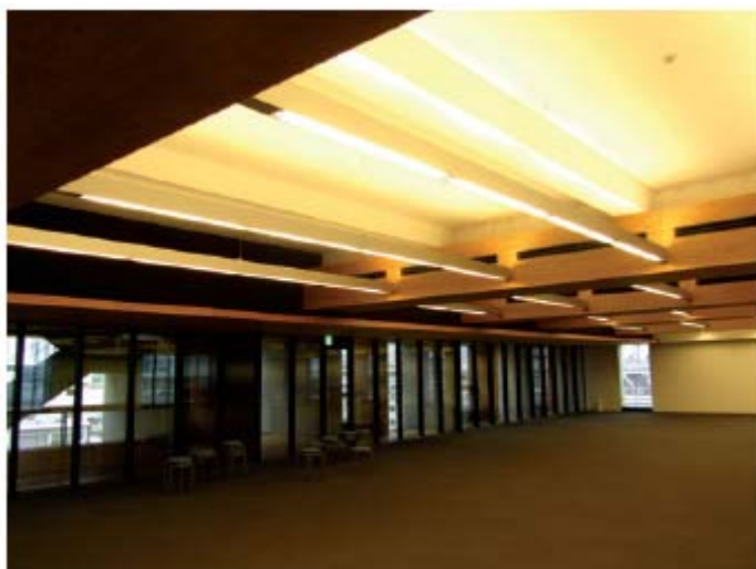
写真 14—金属製の支持構造部—排煙システムの使用により認可された、天井面への木材の利用
