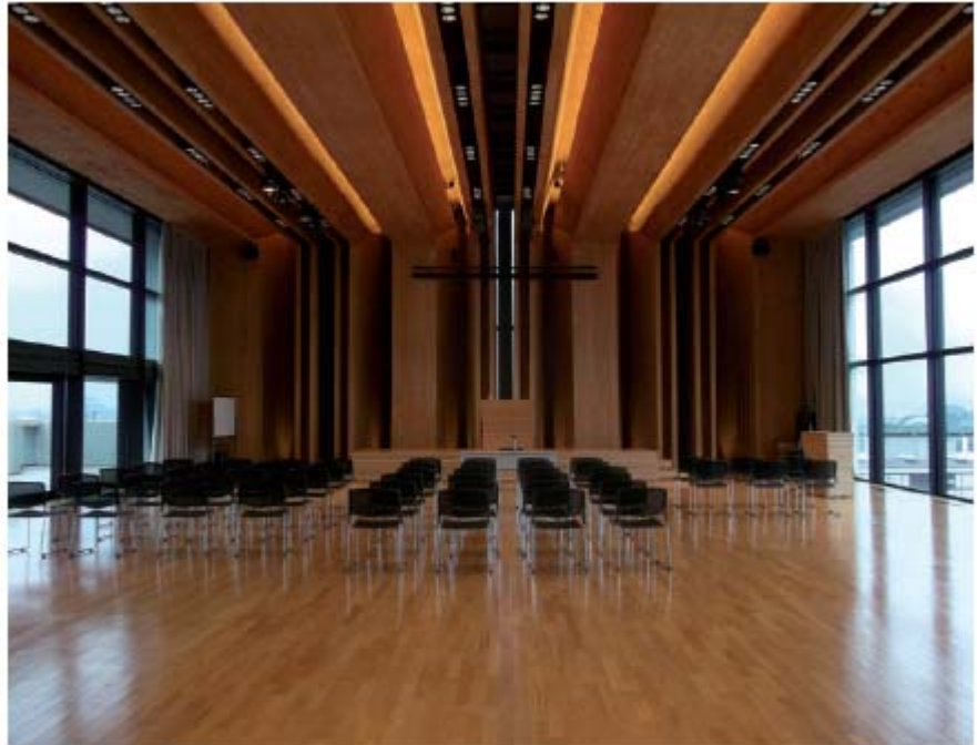
写真 6—不燃処理された木材製の梁—径間 27 m（金属製の骨組み不使用）
