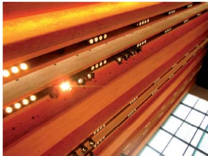
写真 7—天井：ヒノキの構造部と屋外に面したガラス窓
