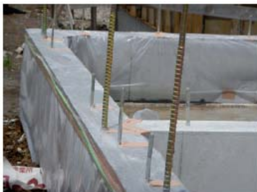
写真 38-木造枠組み壁の設置を待つアンカーロッド
