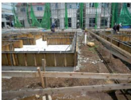
写真 37-基礎の壁型枠、全体像および床下空間上のコンクリート製最下床設置と鉄筋の位置決め
