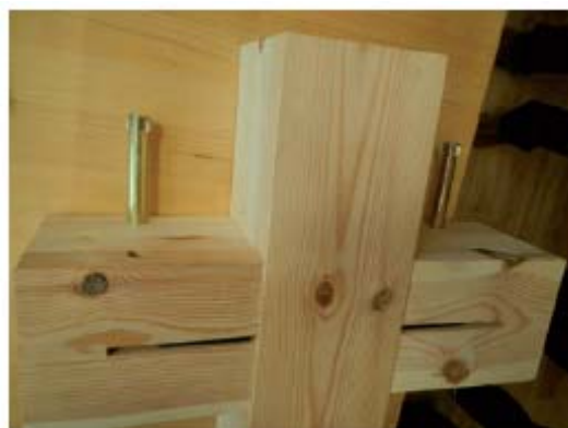
写真 31—金属製の板とピンを用いた「目につかない」力学的接合
