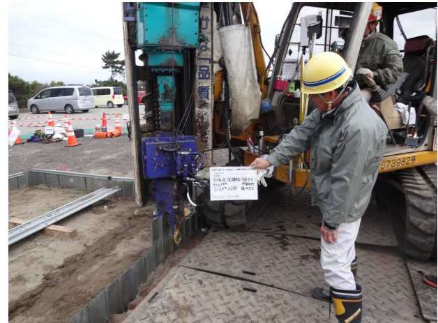
写真 施工状況(現場立会試験時)
